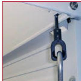
Grâce à la manœuvre de secours, vous pourrez manœuvrer la porte même en cas de coupure de courant.
